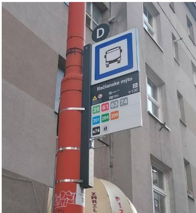
Obrázok 121_Příklad označníka na existujúcom stĺpe - farebnosť pások nezodpovedá požadovanej farebnosti RAL 7016
