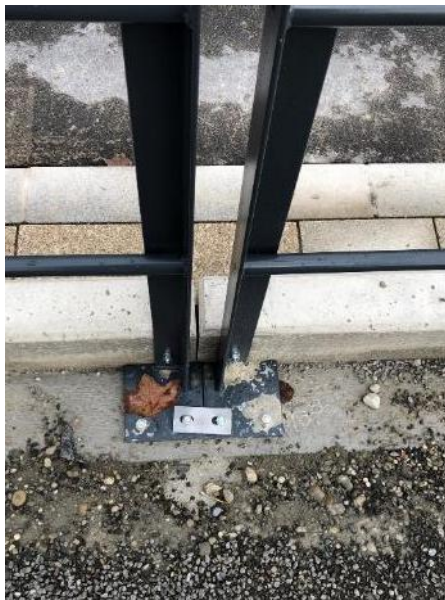
Obrázok 71_Příklad kotvení zábradlí pod povrchem dlažby - detail
